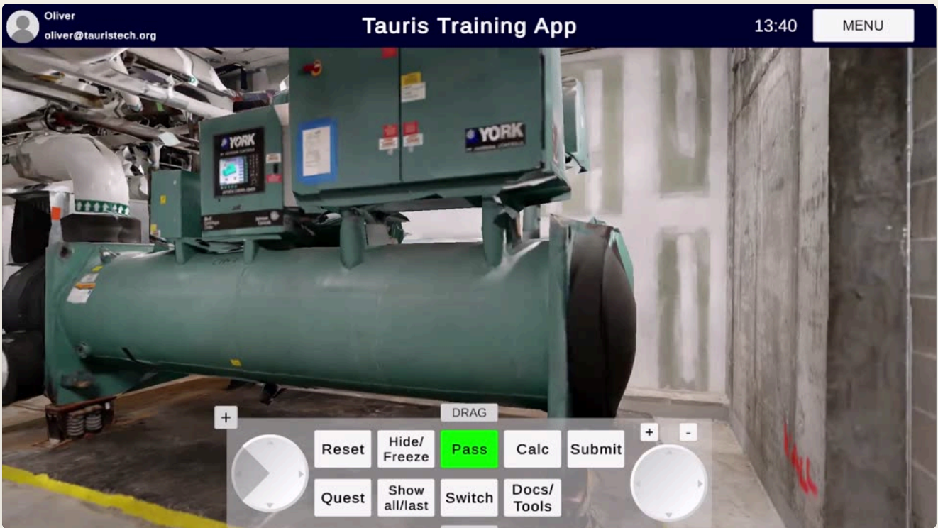
FIG. 03.2 Centrifugal chiller
